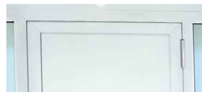
EINSEITIG FLÜGELÜBERDECKEND INNENANSICHT
